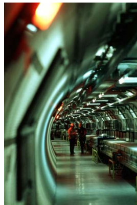
Tunnel du LEP (1991)
