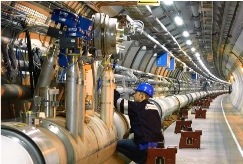
ligne cryogénique avant la pose des aimants
