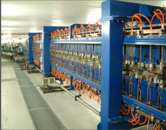
HU 640 : ligne DESIRS (5 eV – 50 eV : Ultra Violet)
