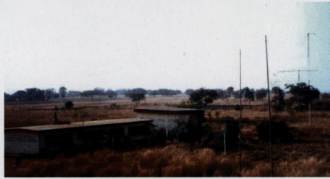
Le bâtiment principal de la station de Korhogo
