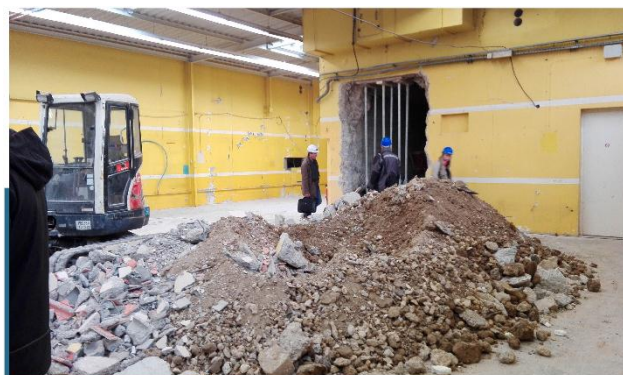
Percement du corridor de circulation entre la future salle de contrôle et le bunker
